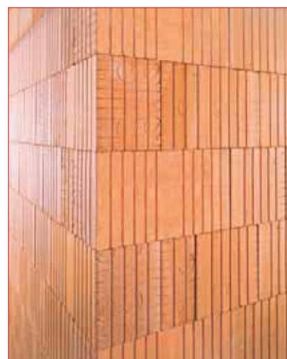
Vnější pohled na správně provedenou vazbu rohu systému broušených cihel POROTHERM CB
