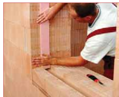
Vyplnění drážek pásy extrudovaného polystyrenu
