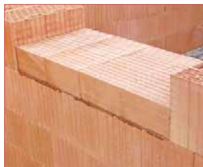
Dokončený parapet s použitím polovičních koncových cihel POROTHERM 1/2 K CB
