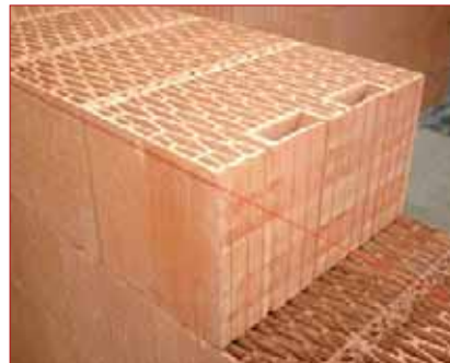
První založená vrstva ostění zakončená koncovou cihlou POROTHERM K CB
