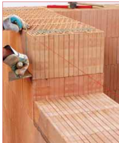
Dokončený parapet s použitím polovičních koncových cihel POROTHERM 1/2 K CB
