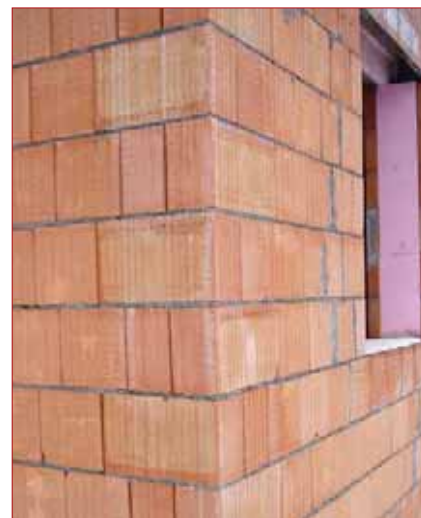
Vnější pohled na vazbu rohu u systému POROTHERM Si
