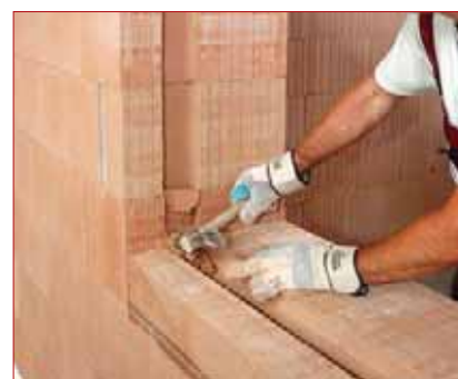
Opatrné vyklepnutí přepážek otvorů v koncových cihlách
