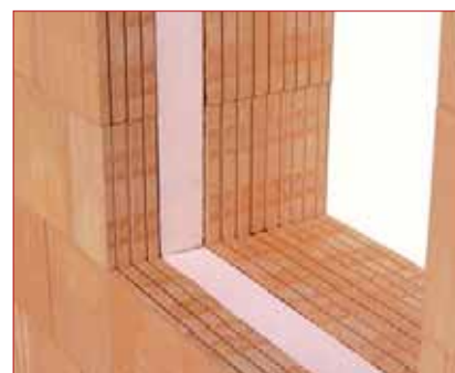
Stavební otvor je připraven pro osazení rámu okna
